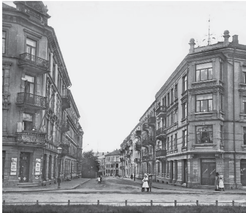
Neberggata med sine nye «demokratiske», ensformige bygårder med mange likeartede balkongrekkverk, sett fra Valkyrie plass, ca. 1910. Foto: Thorkel Jens Thorkelsen (Digitalt museum/Oslo Museum).
