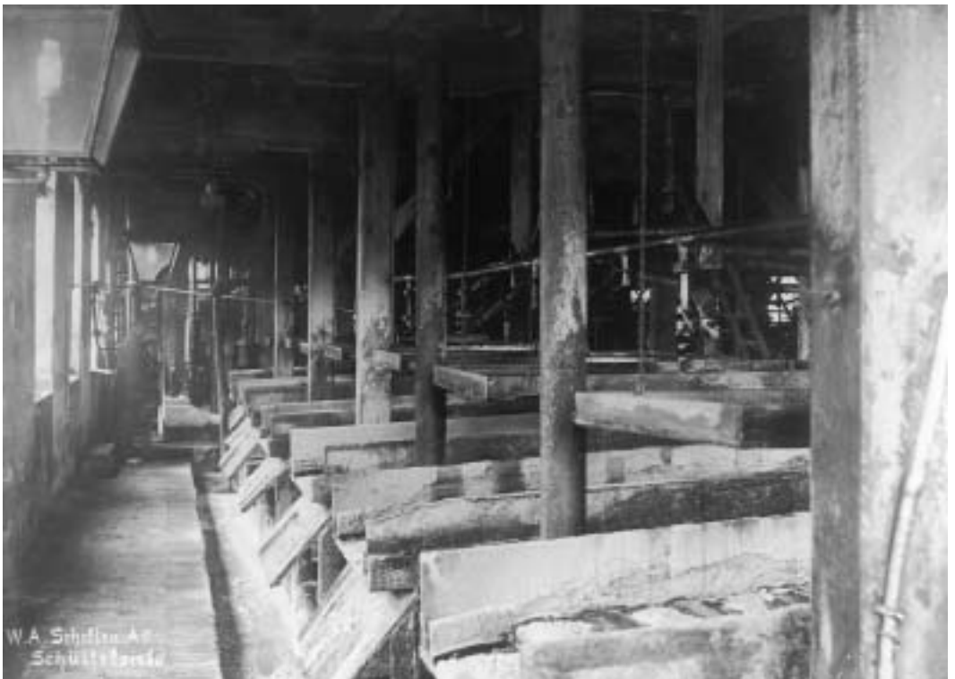
Het zeefvertrek in de fabriek in Brandenburg omstreeks 1920. Hier werd het meel van het water en pulp gescheiden
